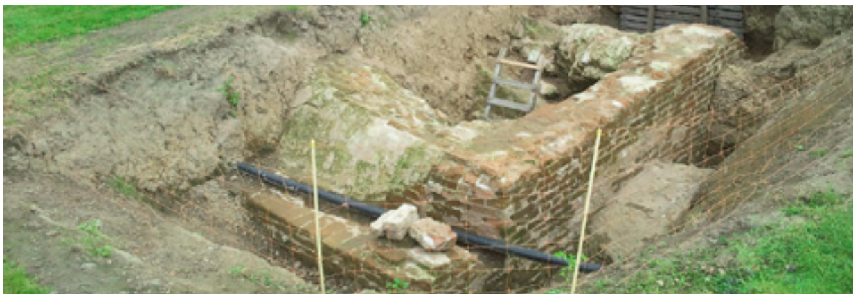
blootgelegd deel van ingestorte ondergrondse kazemat
