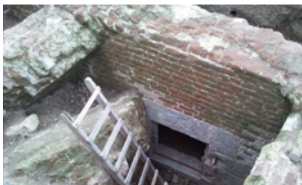
zicht in ingestorte ondergrondse kazemat met geschutsopening
