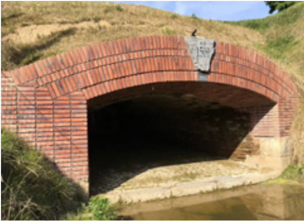
nieuw gemetseld front tegen oude geschutstrechter
