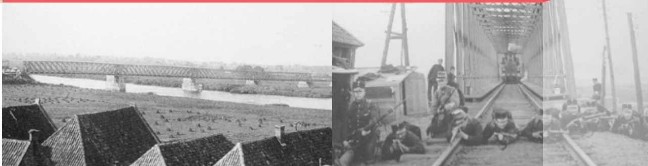
het strategisch landschap in en om Ravenstein: spoorbrug over de Maas
